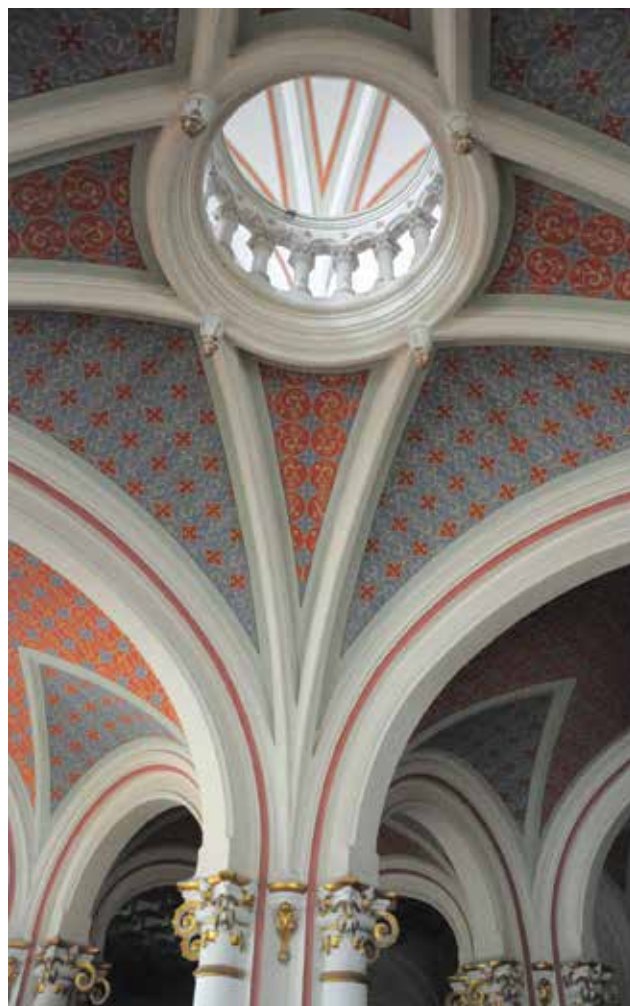
A kecskeméti városháza emeleti előcsarnokának fődémáttörése Opening in the ceiling of the upstairs vestibule of the Kecskemét townhall Fotó: Mester Éva
