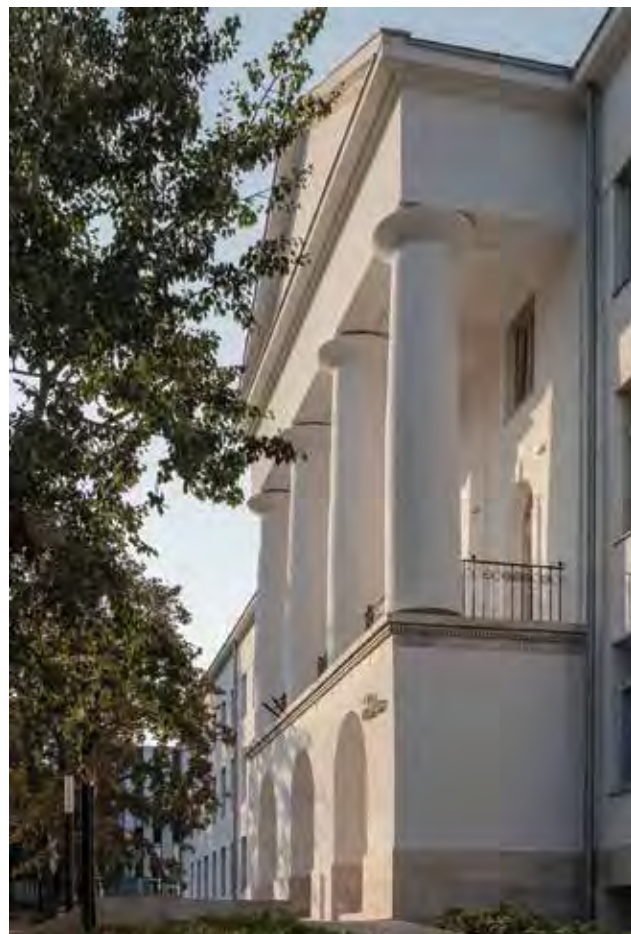
MOME MASTER (mesterfokú képzési épület). Rekonstrukció és bővítés: 3h Építésziroda MOME MASTER (master training building). Reconstruction and enlargement: 3h Architecture © MOME, fotó: Bujnovszky Tamás
