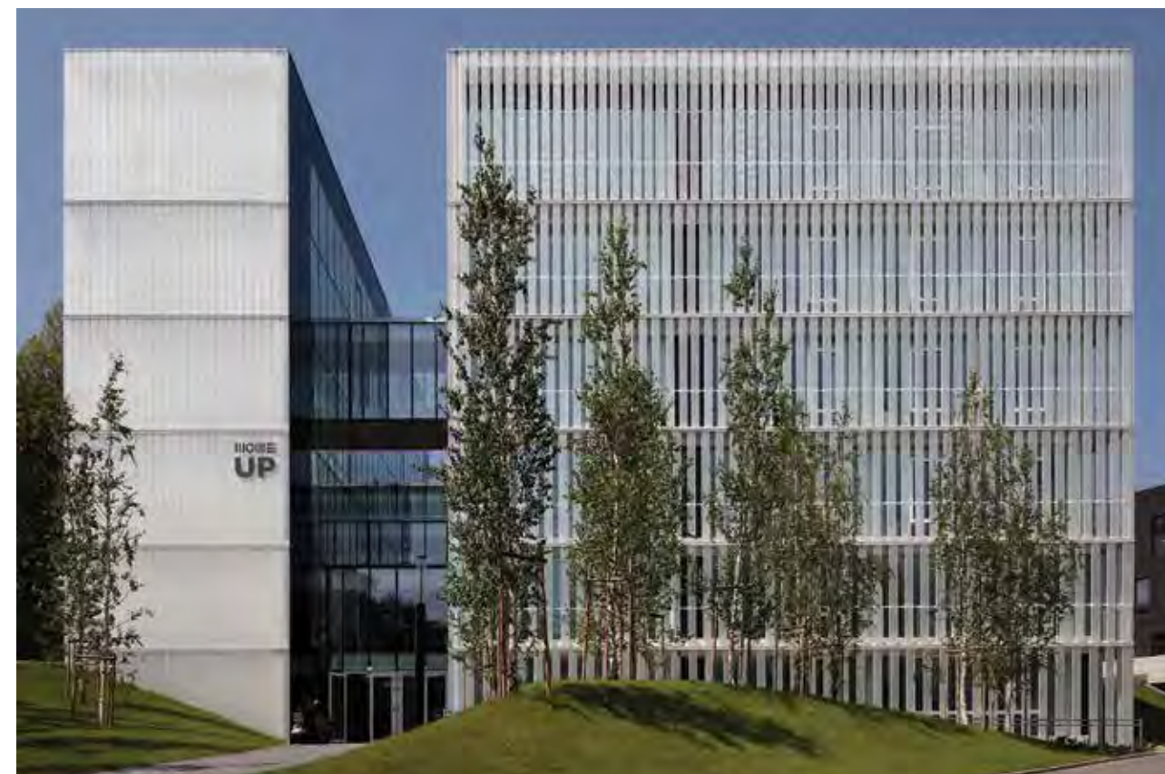
3h Építésziroda: MOME UP (Innovációs Központ, Doktori Iskola, Könyvtár) | 3h Architecture: MOME UP (Innovation Centre, Doctoral School, Library) © MOME, fotó: Bujnovszky Tamás
