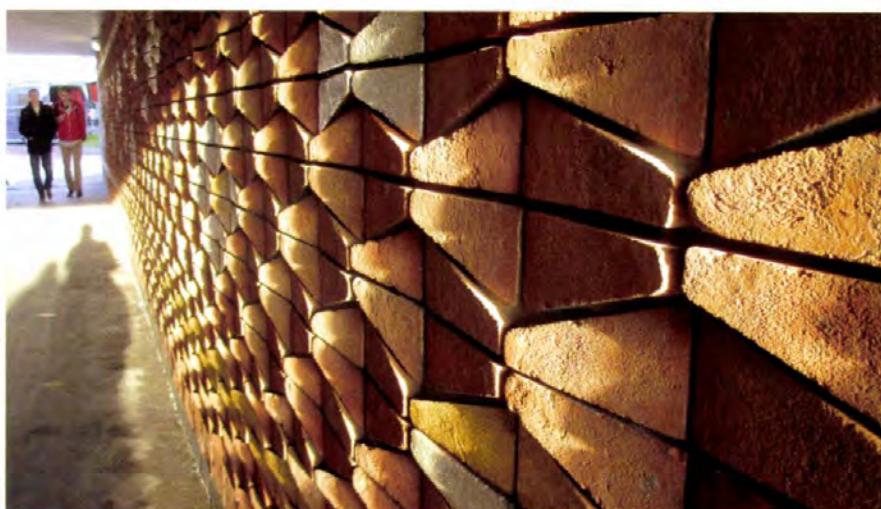
NAGY Márta: Alagútburkolat. Garden – Homage to the Gardens of Delft (részlet), Hamtunnel, Delft Márta NAGY: Garden – Homage to the Gardens of Delft. Tunnel covering (detail), Hamtunnel, Delft 2013
