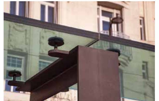
Üvegvezetékű, háromrétegű üvegtető a 2-es villamos megállójában a Kossuth téren, Budapest V. Tervező: Középülettervező Zrt. (KÖZTI). Kivitelező: KÉSZ Építő Zrt., 2012–2014 Three-layer glass canopy producing a greenhouse effect in the stop of tram no. 2, Kossuth tér, Budapest V. Designer: Középülettervező Zrt. (KÖZTI). Producer: KÉSZ Építő Zrt., 2012–2014 Fotó: Zimmermann Eliza Hanna
